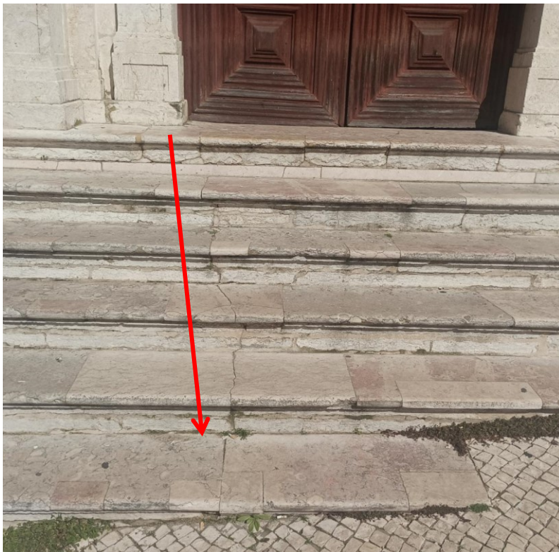
Fig. 11 A seta indica um conjunto de fracturas nos blocos que atravessam a escadaria num desenvolvimento transversal.
