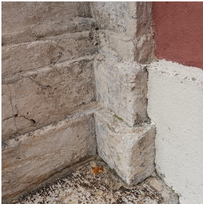
Fig. 9 Soco de alvenaria (revestido a cimento?), lado direito da fachada.
