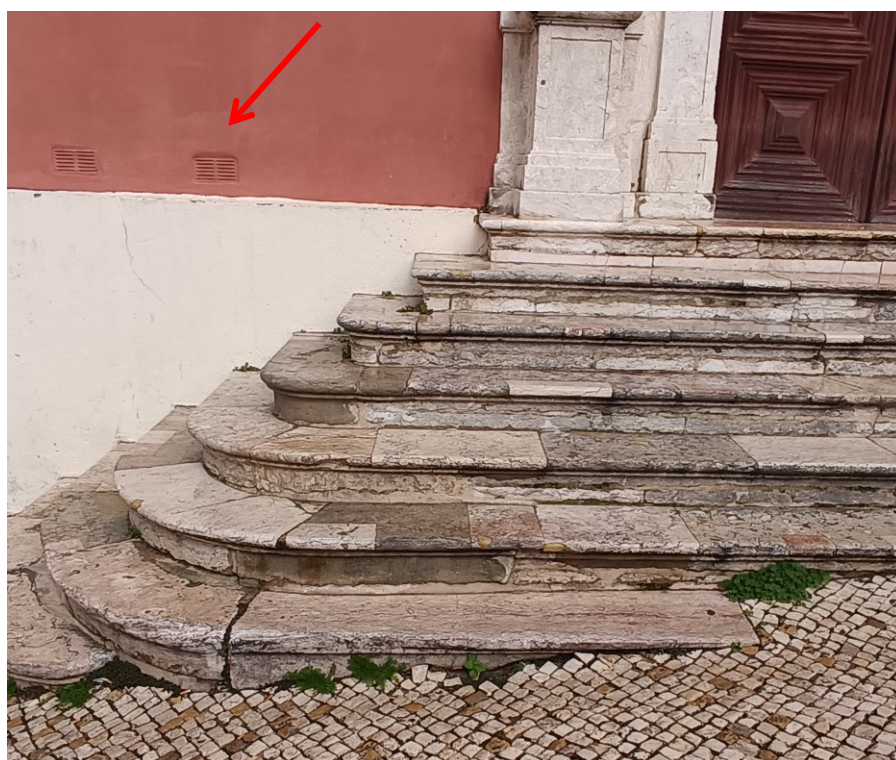
Fig. 8 Soco de alvenaria, lado esquerdo da fachada. Acima deste, duas grelhas (respiradores?).
